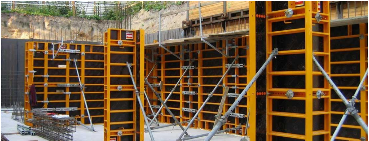
Рисунок 3.1 – приклад збірно-розбірної регульованої малощитової опалубки [26]
