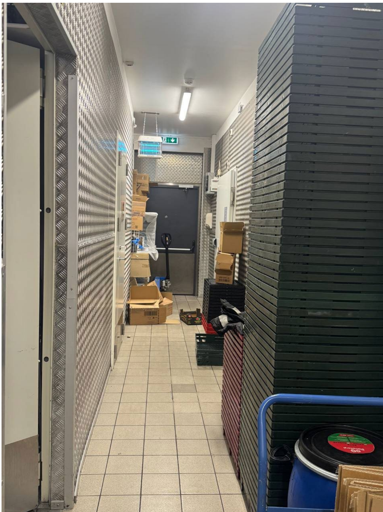
Рисунок Г.8 – Фактичний стан евакуаційного коридору складського блоку та накопичення оборотної тари на шляху до виходу
