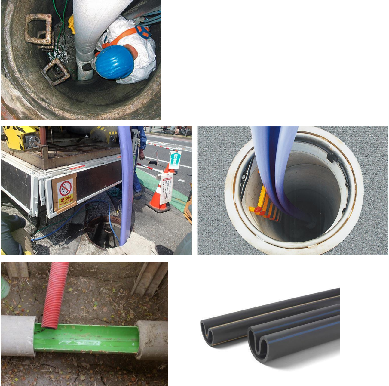
Рисунок 3.1 - Протягування U-подібної та \Omega -подібної полімерної труби
