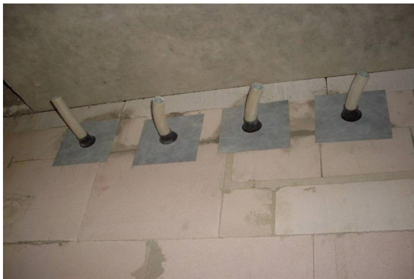
Рисунок 11.1 – Перетин герметичних огорожувальних конструкцій інженерними мережами
