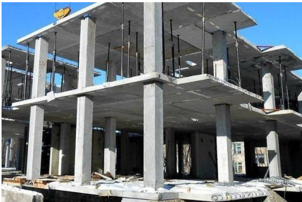
Рисунок 4.1 – Монолітний каркас будівлі
