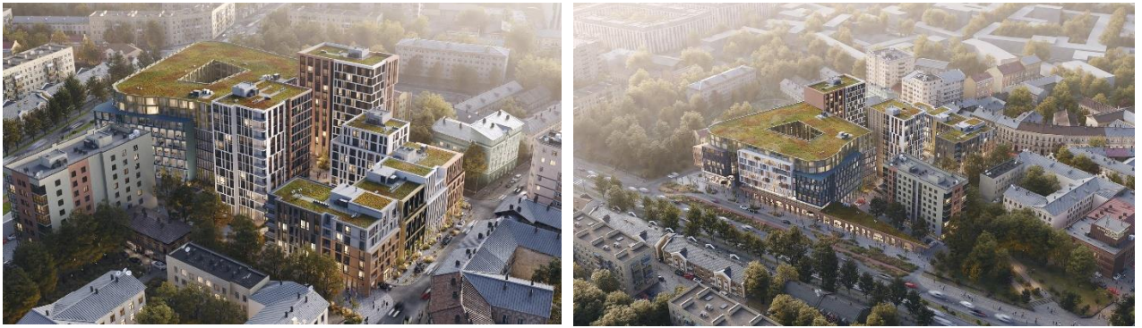
Рисунок 11. Вигляд на комплекс зверху
