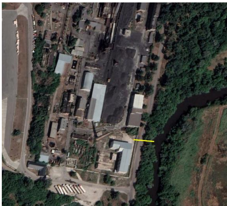
Рисунок 2.16 – Приклад порушення режиму прибережної захисної смуги на р. Лопань
