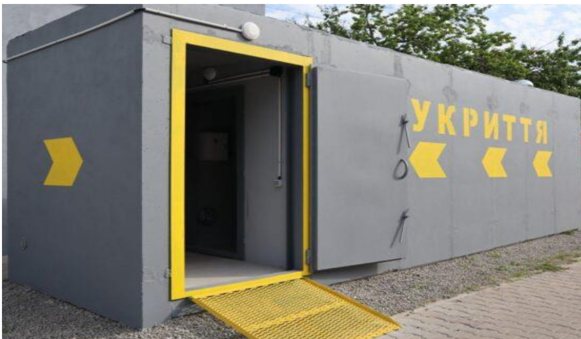
Рисунок 4.3 Влаштування модульного укриття в умовах будівельного майданчику
