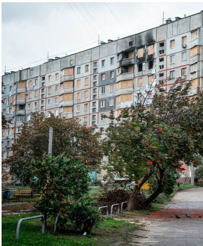
Рисунок 1.7 – Постраждала внаслідок російської агресії будівля, яка потребує реконструкції (сучасний вигляд)
