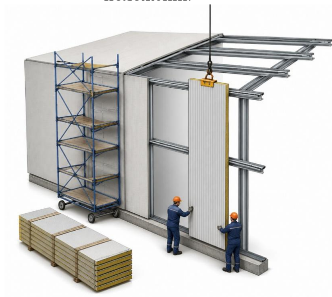
Рисунок 3.7 – Встановлення стінових панелей із застосуванням кранового обладнання.
