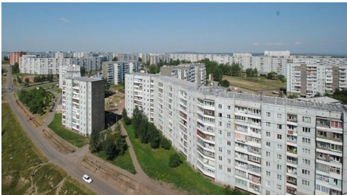
Рисунок А.2 – Загальний вигляд району, у якому розташований об'єкт оцінки
