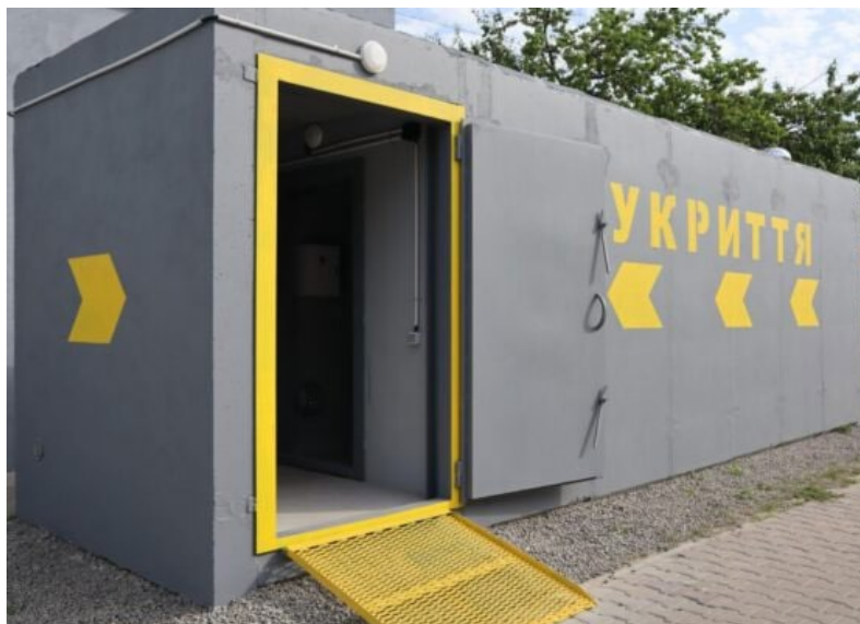
Рисунок 3.4 – Захисна споруда цивільного захисту «Фортеця»
