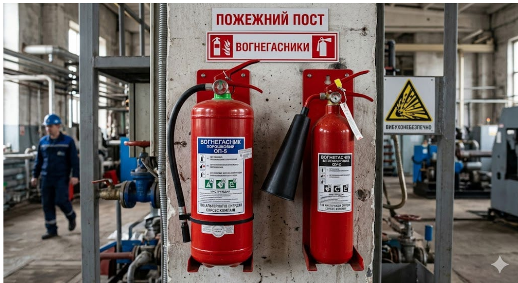
Рисунок 3.1 – Вогнегасники ОП-5 та ОУ-3 на пожежному посту ТОВ «АЛЬТЕРНАТИВ ЕНЕРДЖІ СОРСЕС КОМПАНІ»
