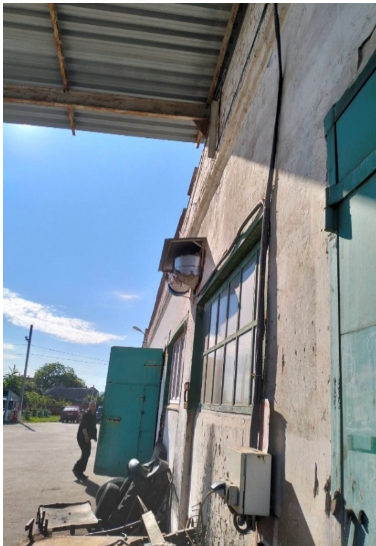
Рисунок 2.1 – Ремонтні бокси КАТП-052810
