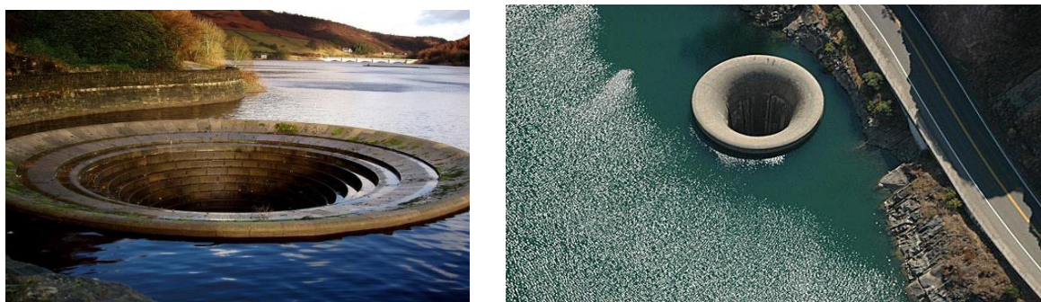
Рисунок 5.5 – Трубчасті водоскиди
