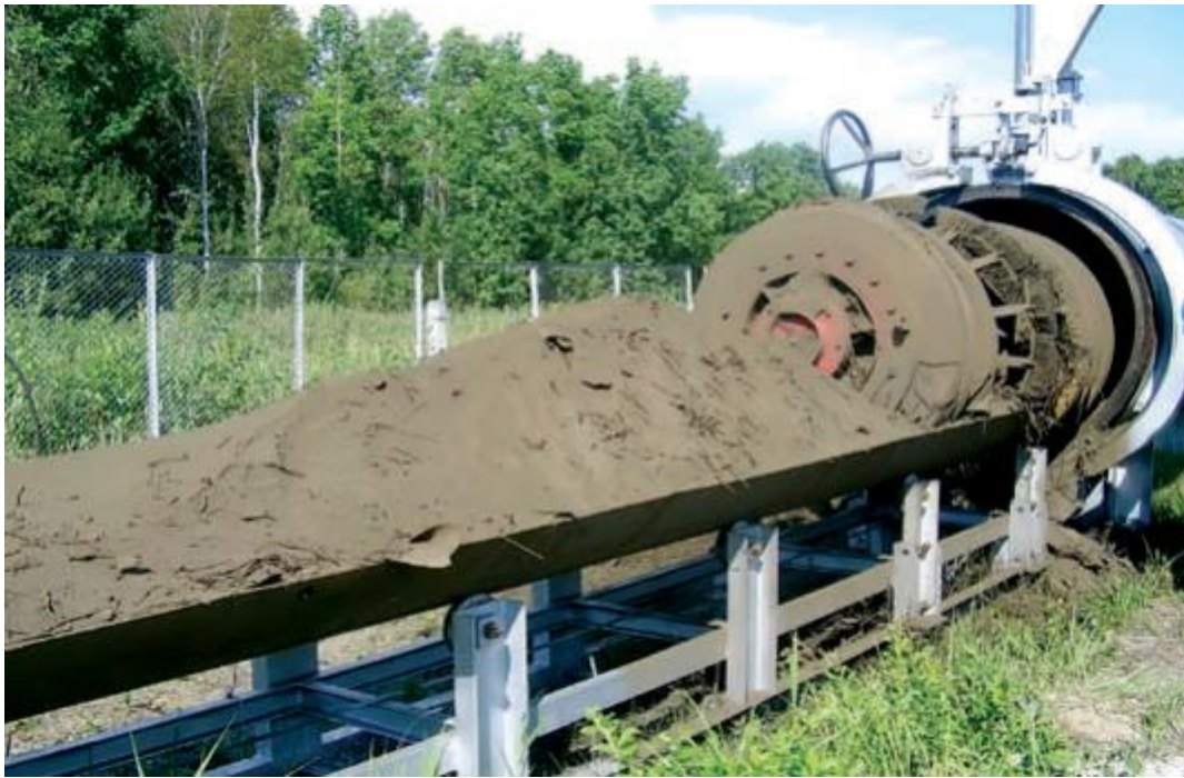
Рисунок 1.4 Очищення ділянок магістрального газопроводу.
