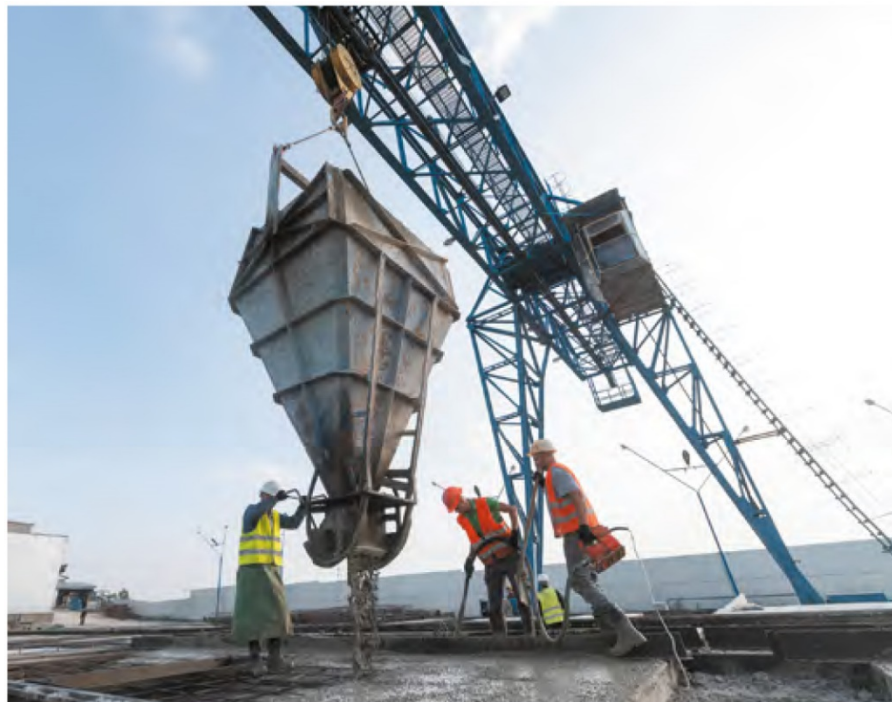
Рисунок 1.3 – Залізобетонні та монтажні роботи [6]
