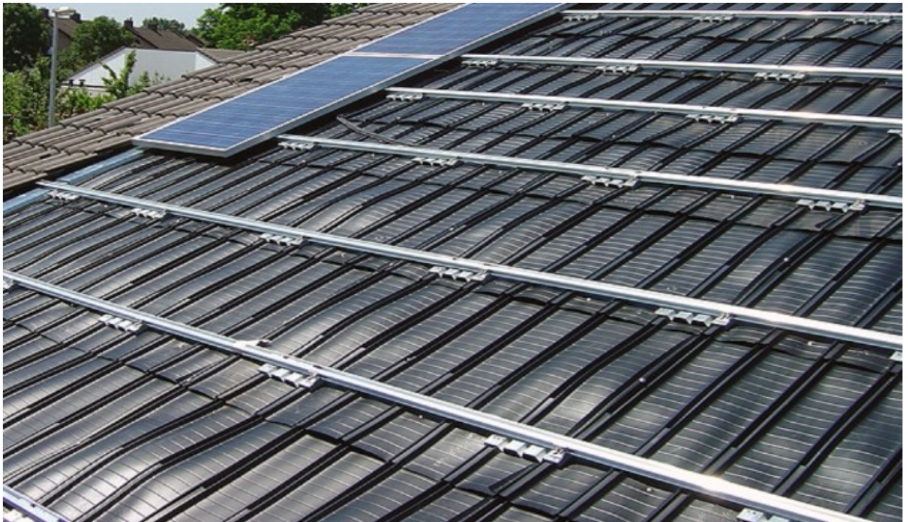
Рис. 4.1 Установка системи сонячних батарей на похилій конструкції
