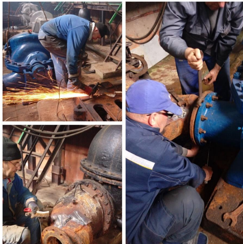
Рисунок 3.1 – Проведення планово-попереджувального ремонту на насосній станції
