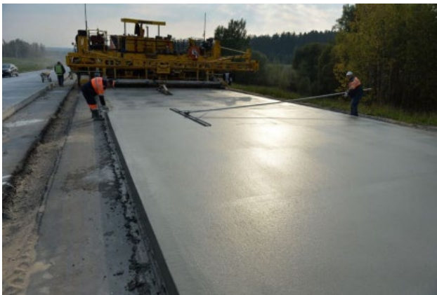
Рисунок 1.2 – Використання фібробетонної суміші
