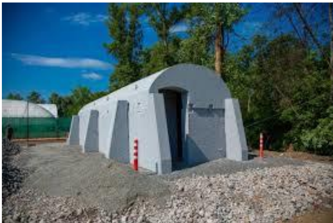
Рисунок 4.1 Модульне укриття на будівельному майданчику
