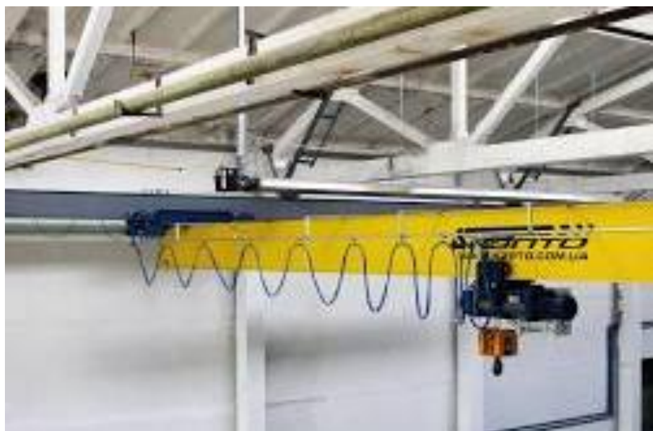
Рис. 26 – Підкранові балки в залізобетонному каркасі.
