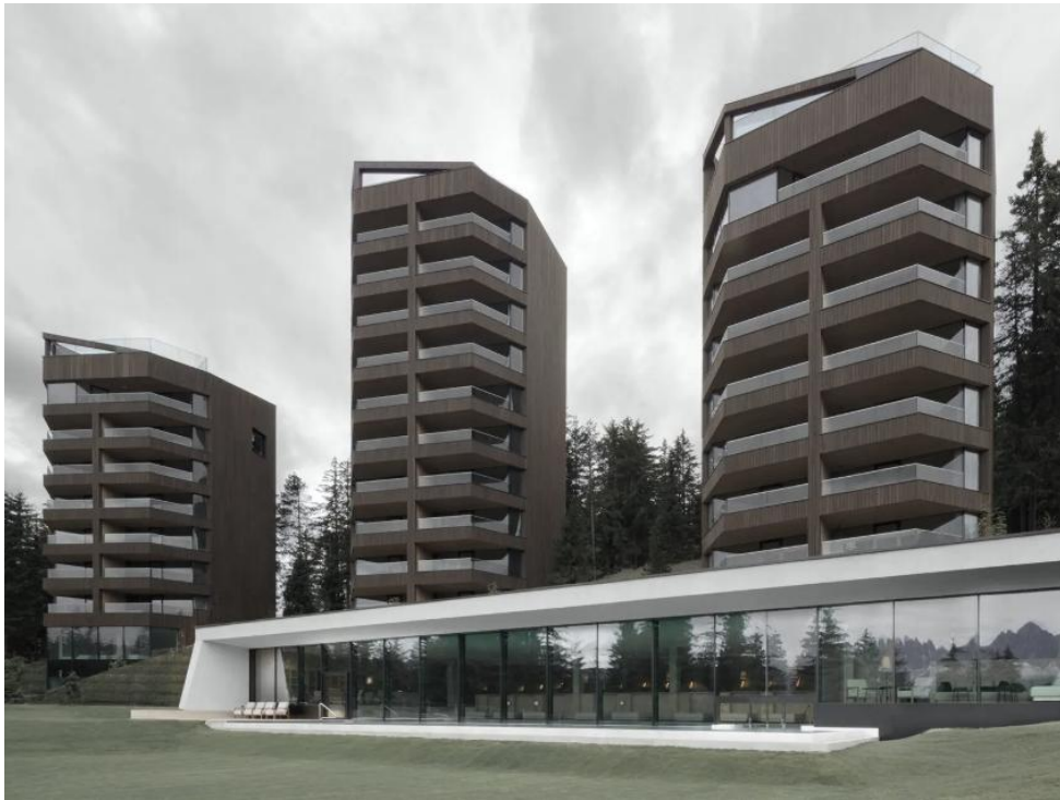
Рис. 6 вигляд будівлі санаторію Forestis Dolomites[14]
