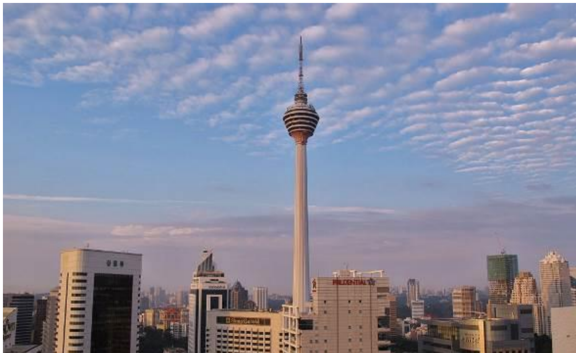
Рисунок 4.4 – Телевежа «Менара» у м. Куала-Лампур, Малайзія, висота 421 м, рік будівництва – 1994. Конструкції – залізобетонні
