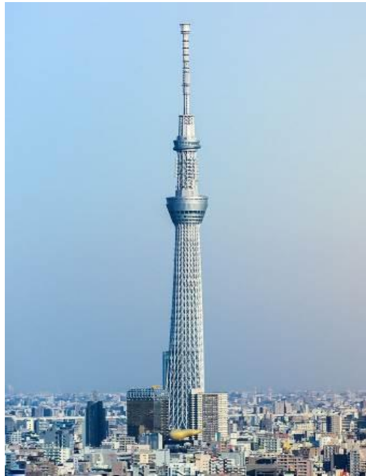
Рисунок 4.1 – Радіотелевізійна вежа «Небесне дерево». Токіо, Японія, найвища вежа у світі. Висота 634 м, рік будівництва – 2012. Конструкції – металеві
