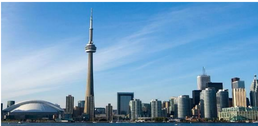
Рисунок 4.2 – Телевежа Сі-Ен Тауер. Торонто, Канада, висота 553,3 м, рік будівництва – 1976. Конструкції – залізобетонні
