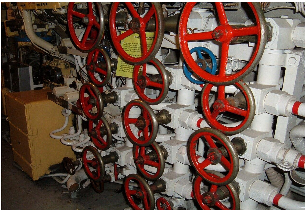
Рис. 8 Маніфольд противикидного обладнання складається з ліній дроселювання і глушіння, які з'єднуються із стволовою частиною
