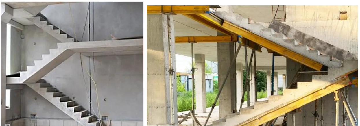
Малюнок 32. Монолітна конструкція сходової клітини
