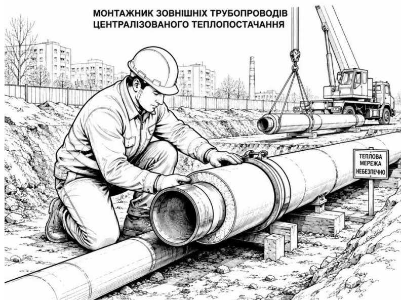
Рисунок 3.1 – Робоче місце монтажника зовнішніх трубопроводів під час виконання робіт з будівництва теплових мереж
