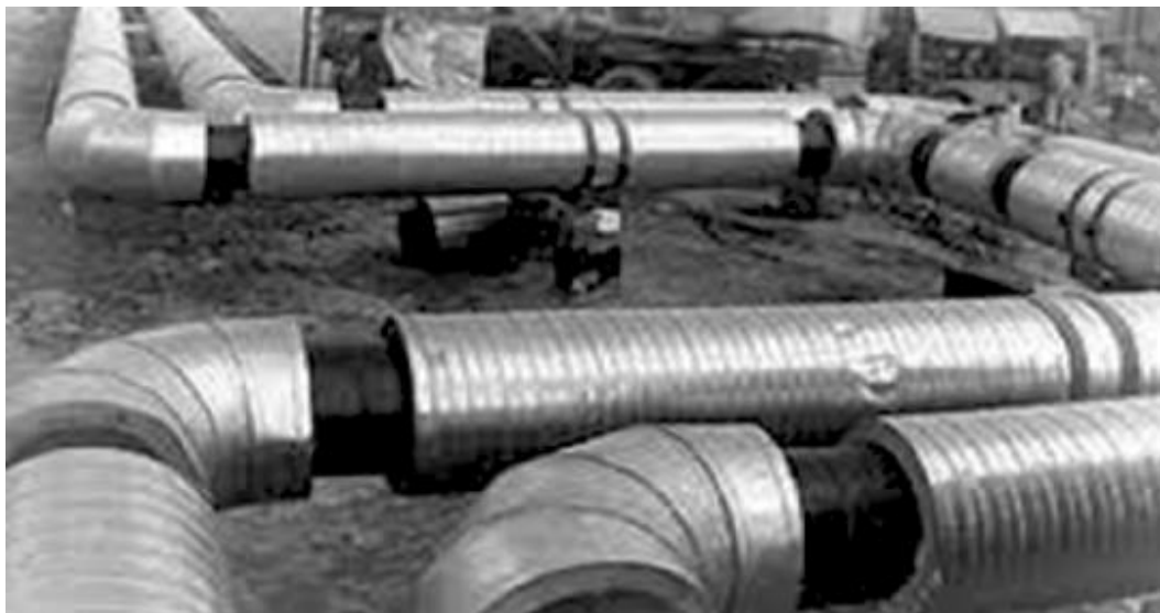
Рисунок 1.4– П-подібний компенсатор для надземної прокладки [6]
