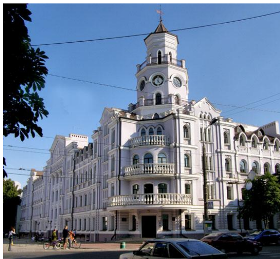
Реконструйована будівля земського суду з пожежною вежою. Нині тут академія банківської справи
