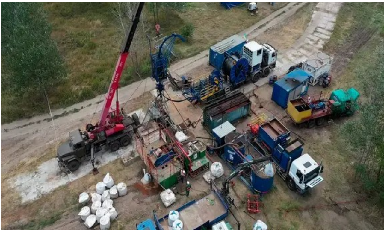
Рисунок 1.16 – Розміщення техніки та обладнання на робочому майданчику під час проведення операцій з КТУ
