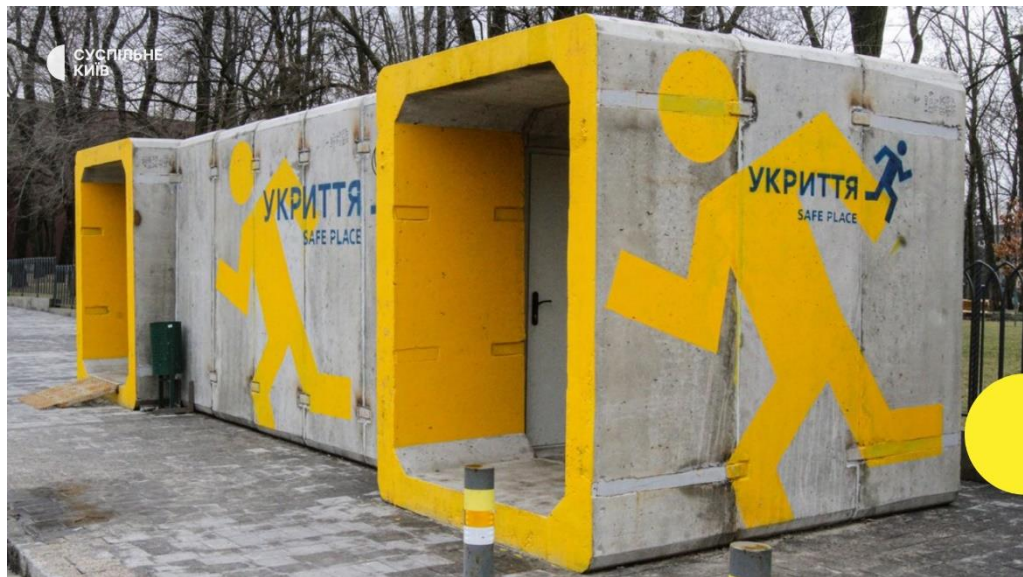
Рисунок 4.1 Влаштування модульного укриття в умовах будівельного майданчику
