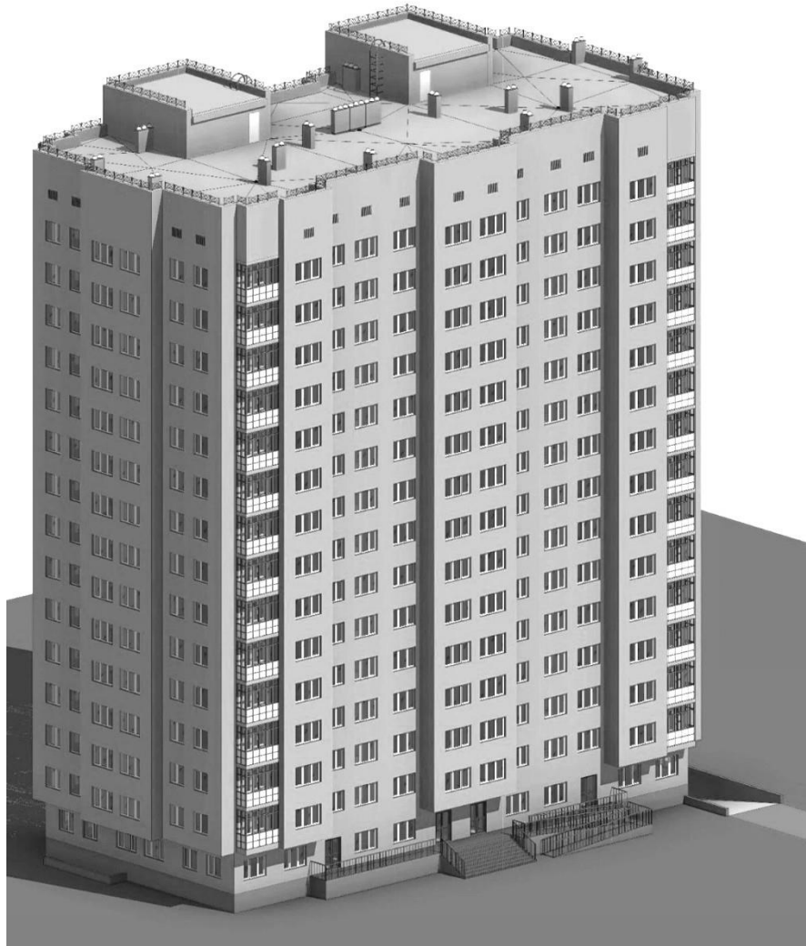
Рисунок 2.6. Загальний вигляд будівлі
