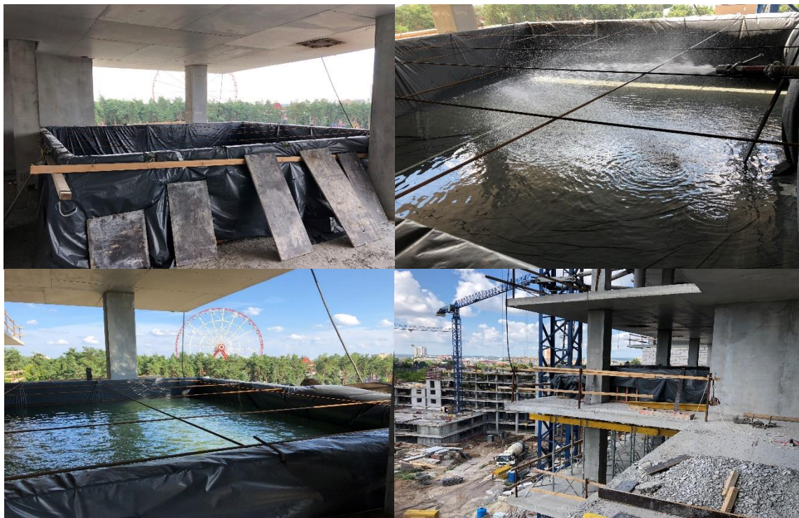
Рисунок 1.8 – Дослідження деформативності монолітного залізобетонного перекриття гідростатичним методом
