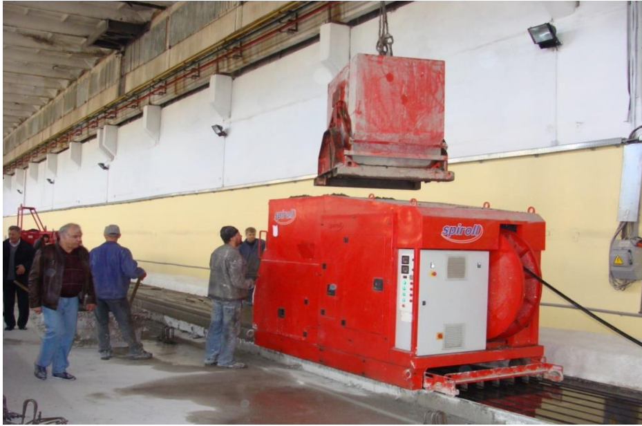
Рисунок 1.2 – Застосування сучасних технологій під час виробництва будівельної продукції (збірні залізобетонні елементи)
