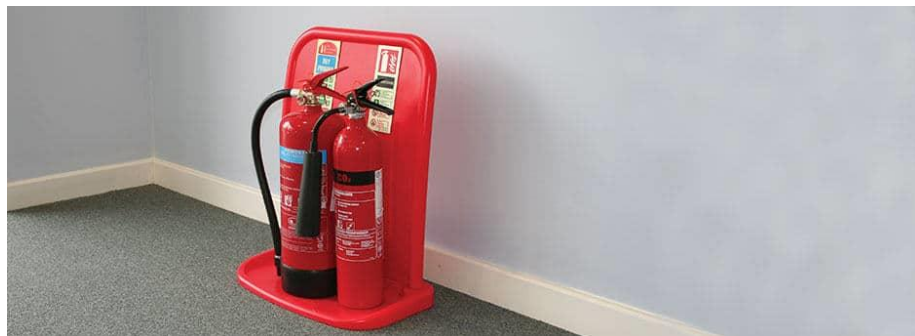
Рисунок 4.1 – Спосіб розміщення вогнегасників
