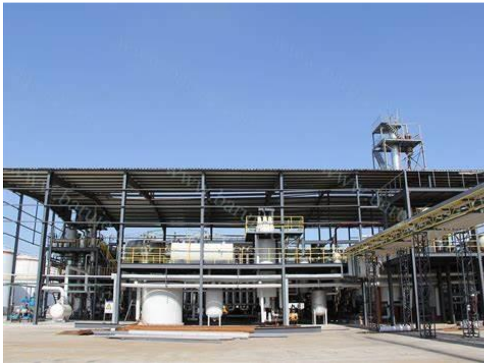
Рисунок 3.1 – Модульна установка переробки рапсового масла в біодизель Lurgi/Alfa Laval
