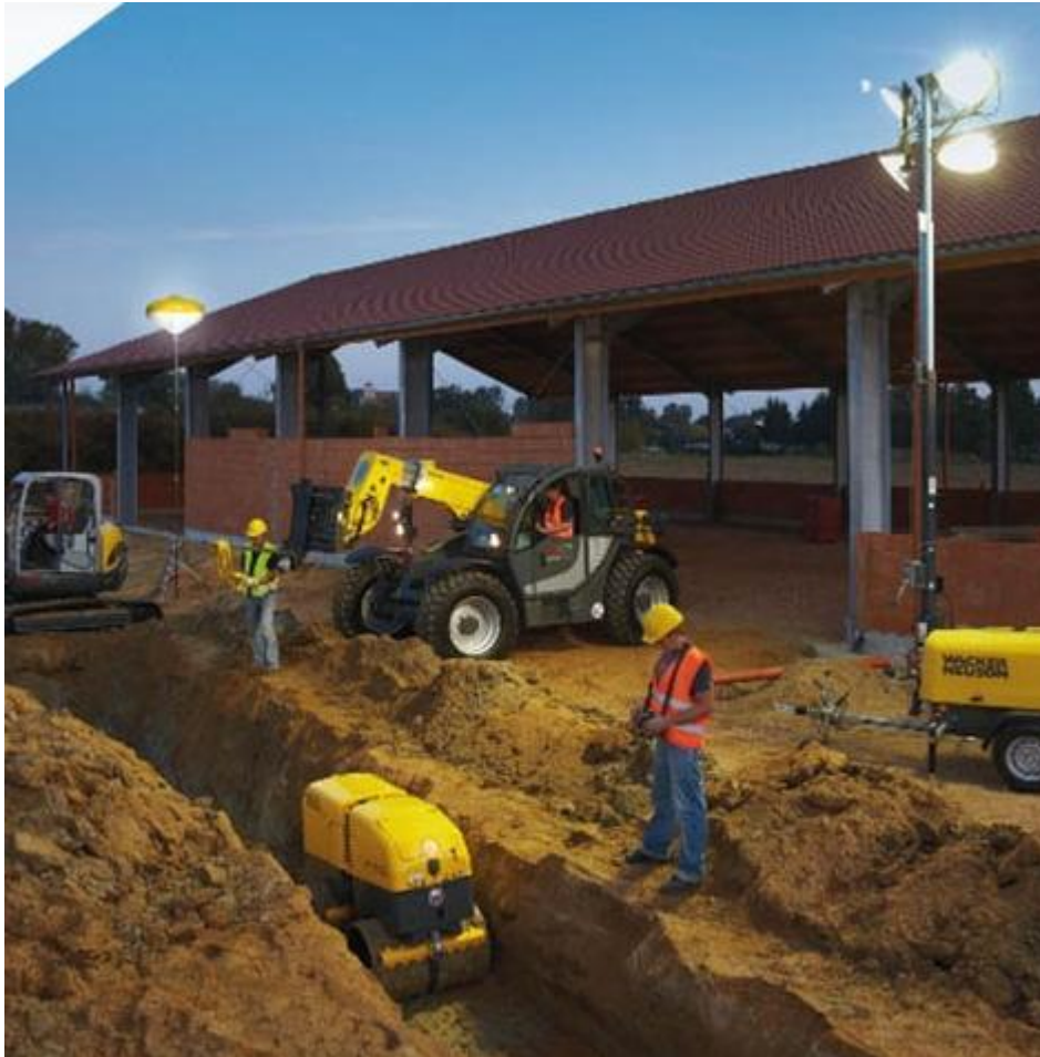
Рисунок 4.1 – Освітлення будівельного майданчика
