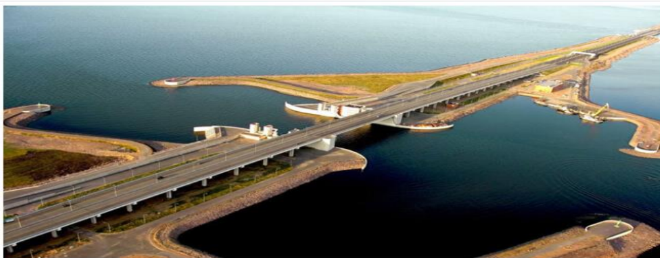
Рисунок 10.6 – Регуляційна споруда (струмененапрямна дамба) (фото з відкритих джерел)
