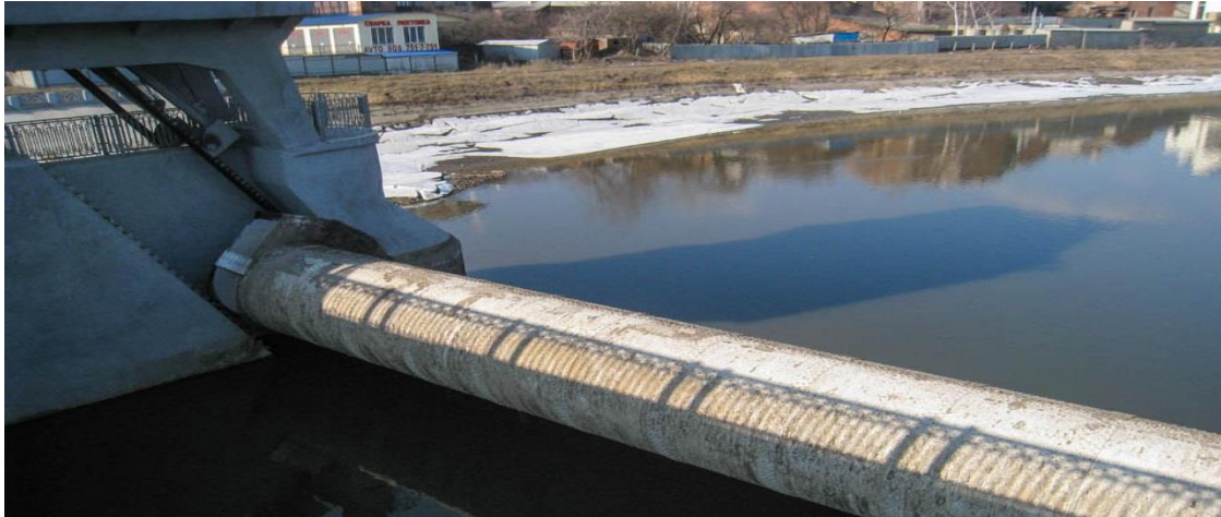
Рисунок 8.18 – Вальцьовий затвор, Гончарівська гребля, Харків, Україна ( https://wikimapia.org/952013/uk/%D0%93%D0%BE%D0%BD%D1%87%D0%B0%D1%80%D1%96%D0%B2%D1%81%D1%8C%D0%BA%D0%B0%D0%B3%D1%80%D0%B5%D0%B1%D0%BB%D1%8F )
