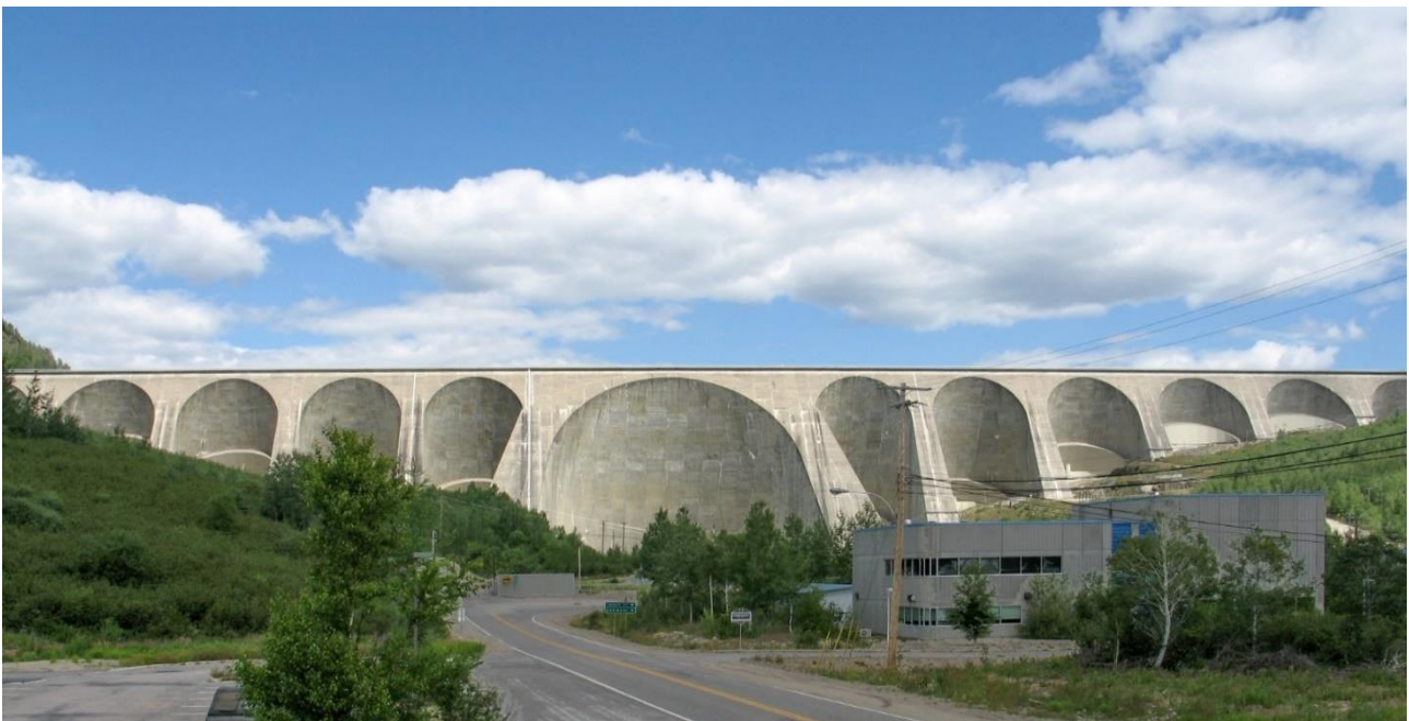
Рисунок 8.8 – Контрфорсна багатоаркова гребля Даніель Джонсон, Канада ( https://uk.wikipedia.org/wiki/%D0%93%D0%95%D0%A1_%D0%9C%D0%B0%D0%BD%D1%96%D0%BA-5 )
