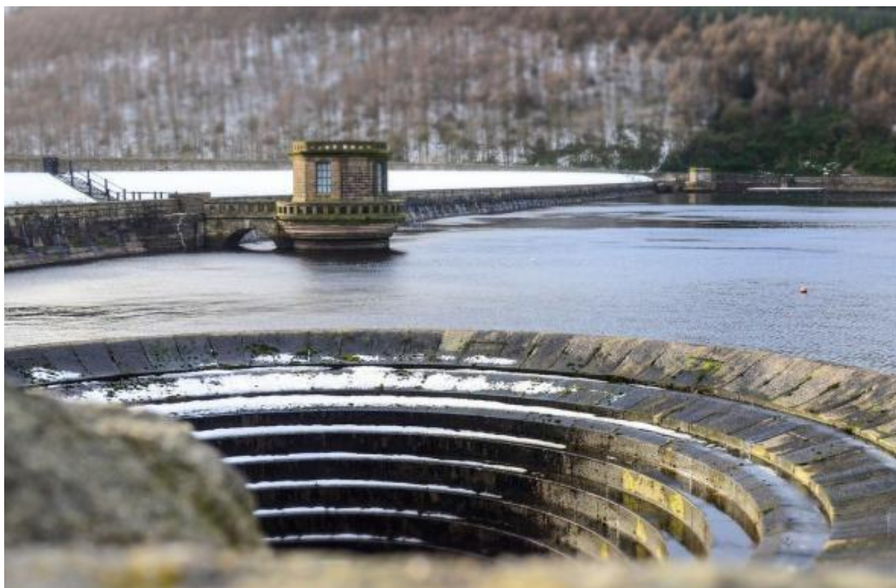
Рисунок 8.14 – Шахтний водоскид на озері Ледібауер, Великобританія ( http://www.cawater-info.net/all_about_water/?p=7714 )
