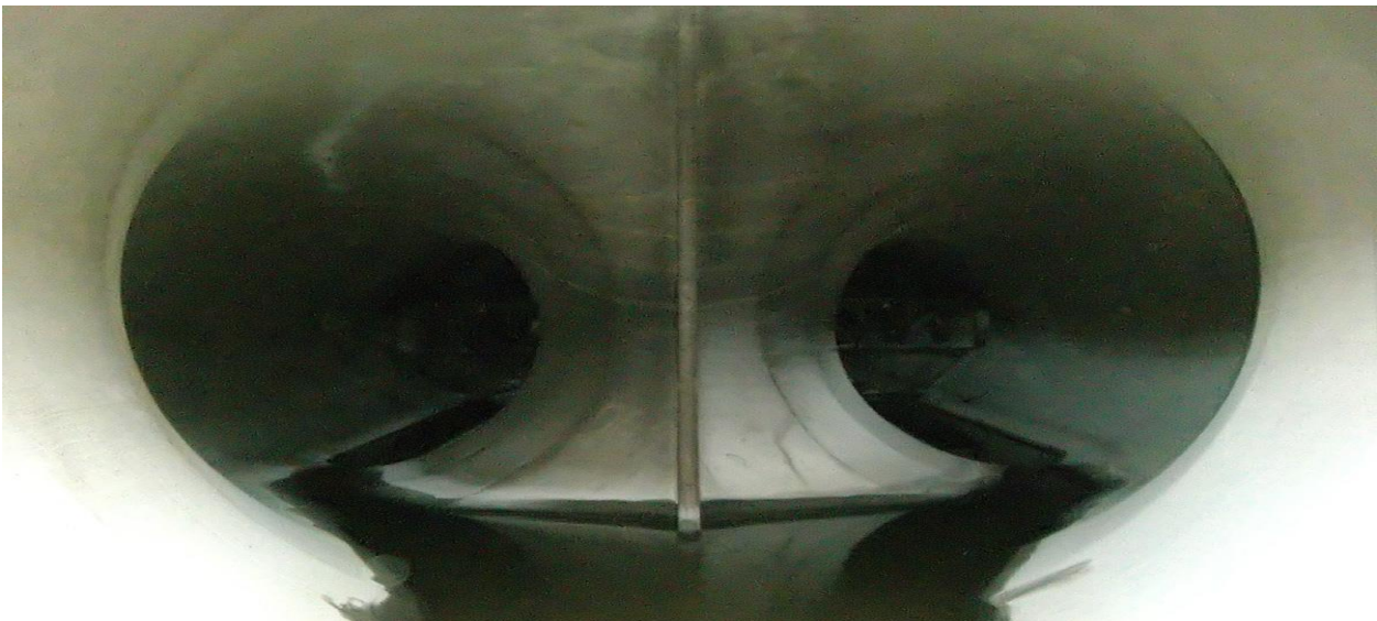
Рисунок 8.16 – Тунель трубчастого водоскиду (фото з відкритих джерел)
