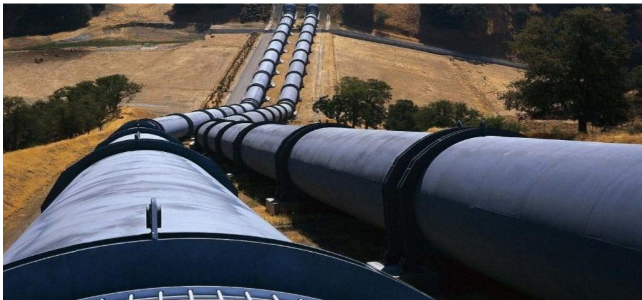
Рисунок 8.30 – Металевий трубопровід (фото з відкритих джерел)
