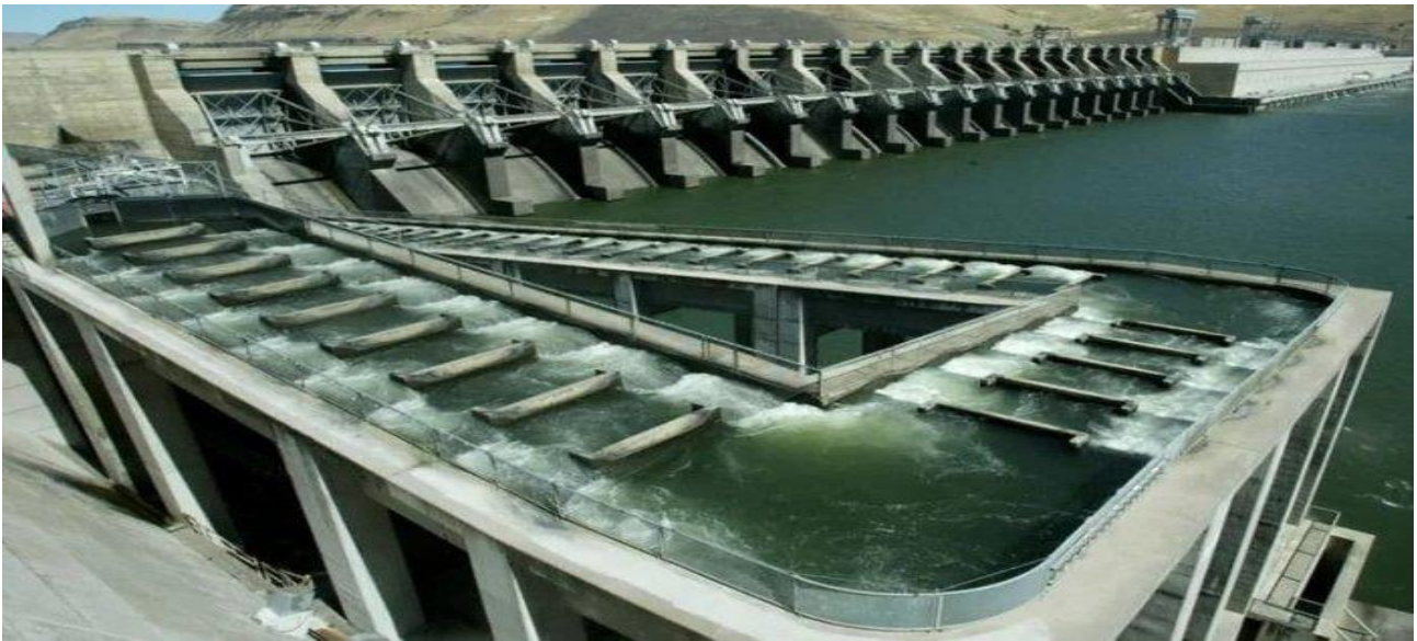
Рисунок 8.43 – Рибопідйомник The John Day Lock & Dam (Колумбія) ( https://uk.wikipedia.org/wiki/%D0%A0%D0%B8%D0%B1%D0%BE%D0%BF%D1%80%D0%BE%D0%BF%D1%83%D1%81%D0%BA%D0%BD%D1%96_%D1%81%D0%BF%D0%BE%D1%80%D1%83%D0%B4%D0%B8 )
