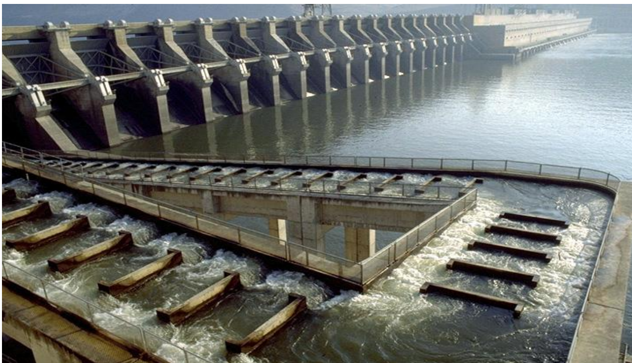
Рисунок 7.7 – Рибопрохід на греблі «Джон Дей» на річці Джон-Дей, США ( https://uk.wikipedia.org/wiki/%D0%A0%D0%B8%D0%B1%D0%BE%D0%BF%D1%80%D0%BE%D0%BF%D1%83%D1%81%D0%BA%D0%BD%D1%96_%D1%81%D0%BF%D0%BE%D1%80%D1%83%D0%B4%D0%B8 )
