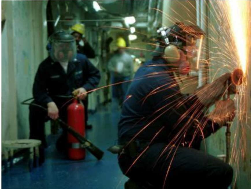
Рисунок 11.1 – Проведення зварювальних робіт із дотриманням вимог безпеки
