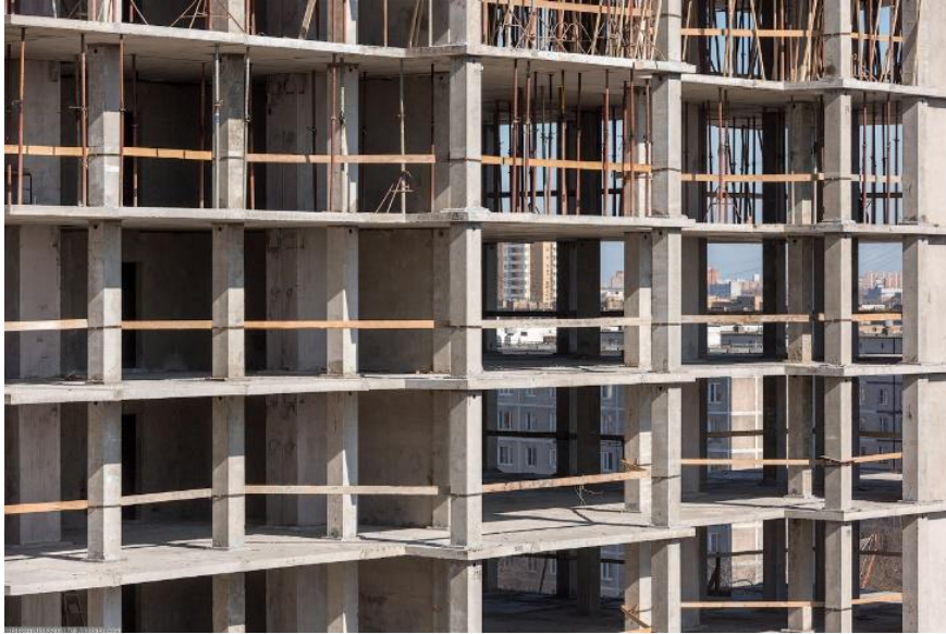
Рисунок 1.27 – Монолітне безбалкове перекриття без капітелей
