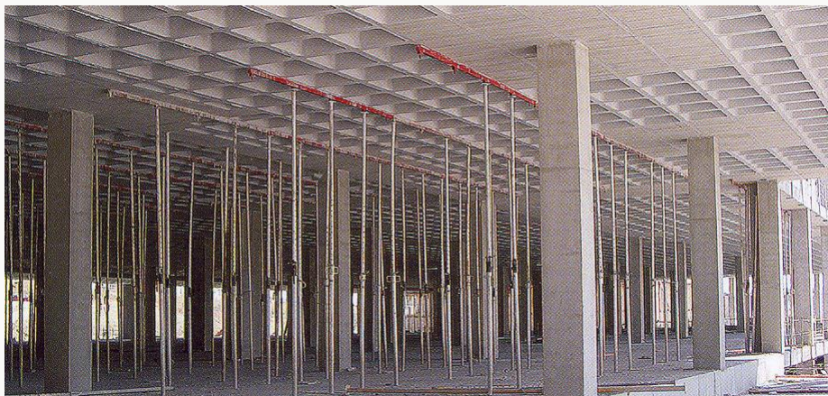
Рисунок 1.14 – Монолітне перекриття кесонного типу
