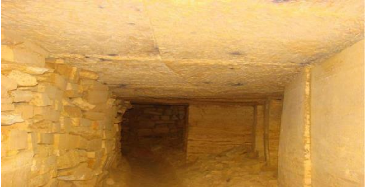
Рисунок 1.3 – Загальний вигляд підземних виробок
