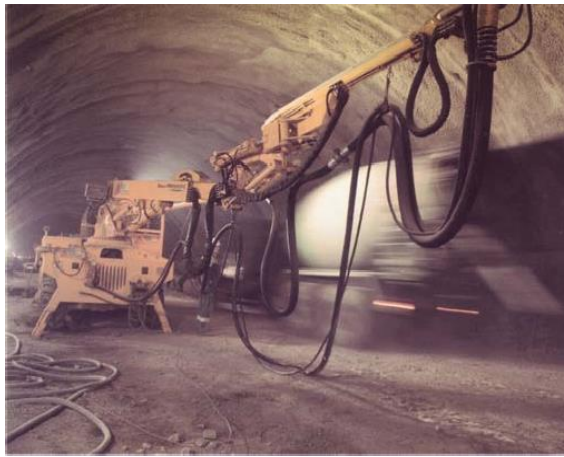
Рисунок 4.11 – Установка для нанесення набрызк-бетону «Sika-Putzmeister»
