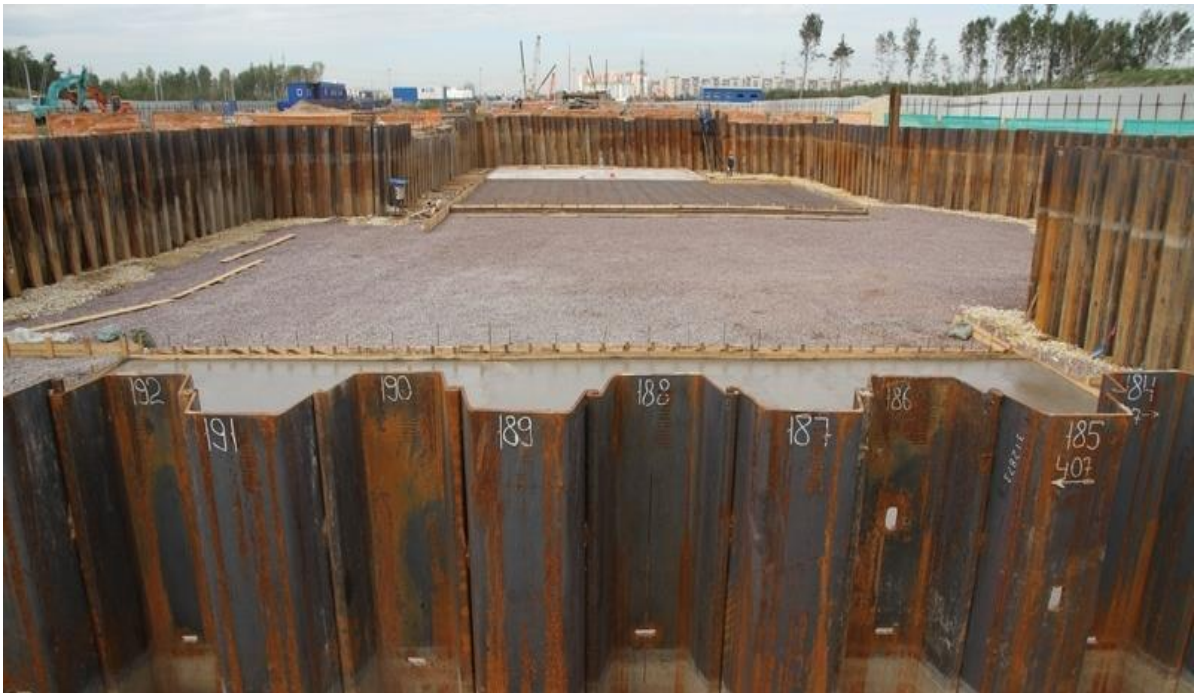
Рисунок 7.2 – Кріплення стінок котловану профільним металом (шпунт Ларсена)
