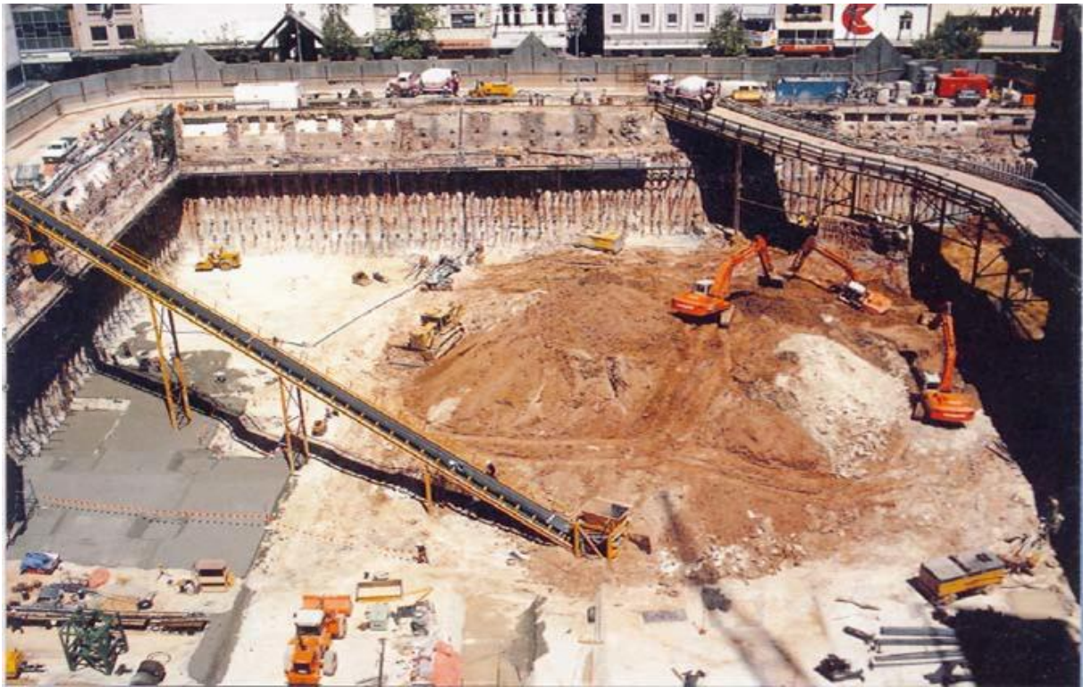
Рисунок 7.11 – Влаштування фундаментів «стіна в ґрунті» з бурових палів, що перетинають у центрі м. Мюнхена (Німеччина)
