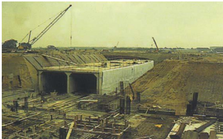
Рисунок 2.16 – Будівництво тунелю в аеропорту «Стенстед» м. Лондона
