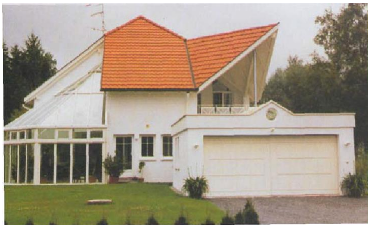
Рисунок 2.4 – Дачний будинок у Ворарлберзі (Австрія), побудований на фундаментах з «енергетичних» паль
