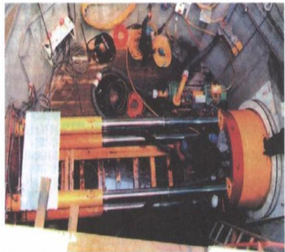
Рисунок 8.6 – Монтаж труб для задавлювання через кільце ущільнювача. Продавлювання труб із стартової шахти на будівництві
