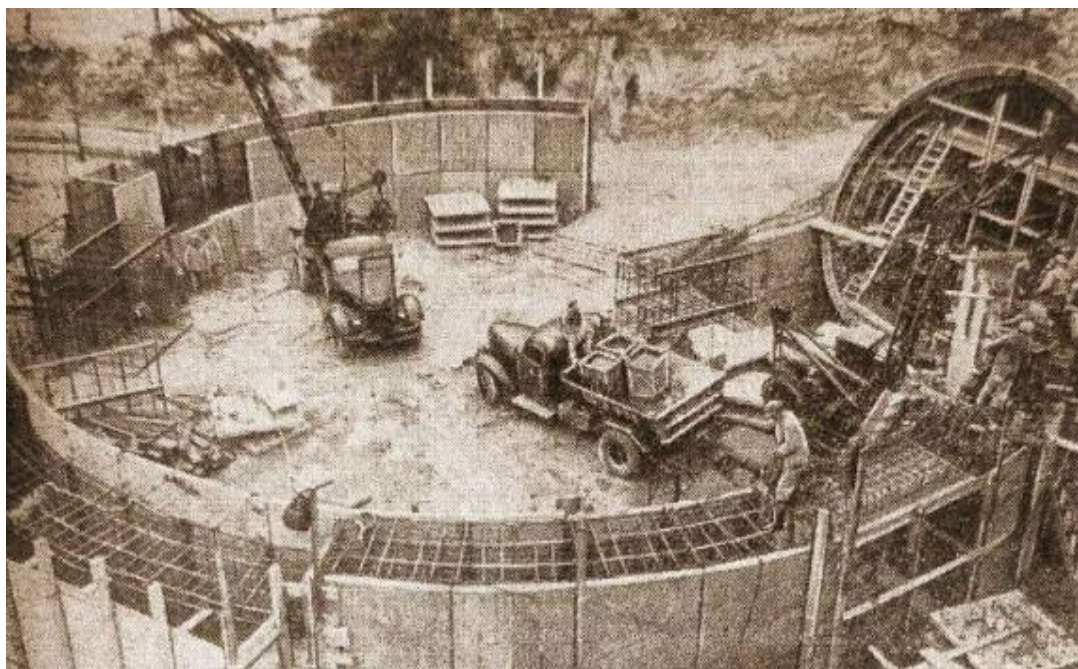
Рисунок 2.12 – Будівництво вестибюлю станції та метро «Арсенальна»
