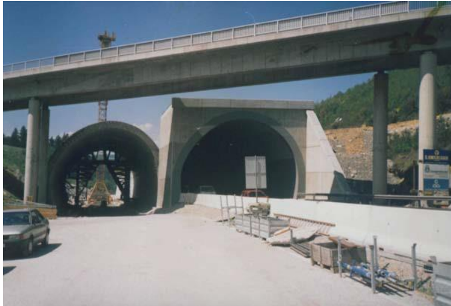
Рисунок 2.11 – Будівництво автодорожнього тунелю на автотрасі Зальцбург – Мюнхен
