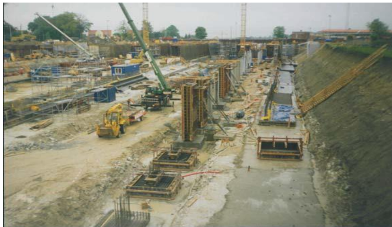
Рисунок 2.15 – Будівництво тунелю у м. Копенгагені
