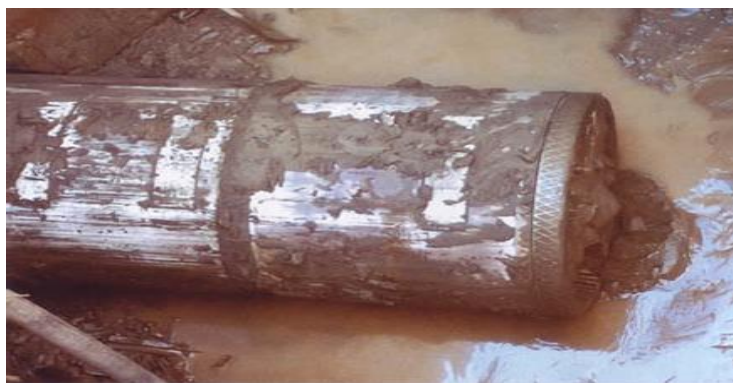
Рисунок 8. 7 – Вихід мікрощита в приймальний котлован
