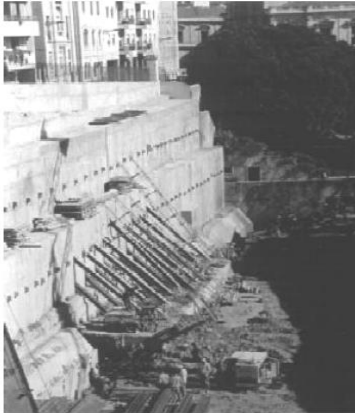
Рисунок 8.15 – Виконання протиаварійних заходів у котловані при активізації зсуву в Лісабоні
