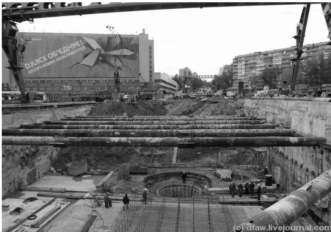
Рисунок 7.4 – Кріплення стінок котловану металевими розпірками під час будівництва метро Деміївська
