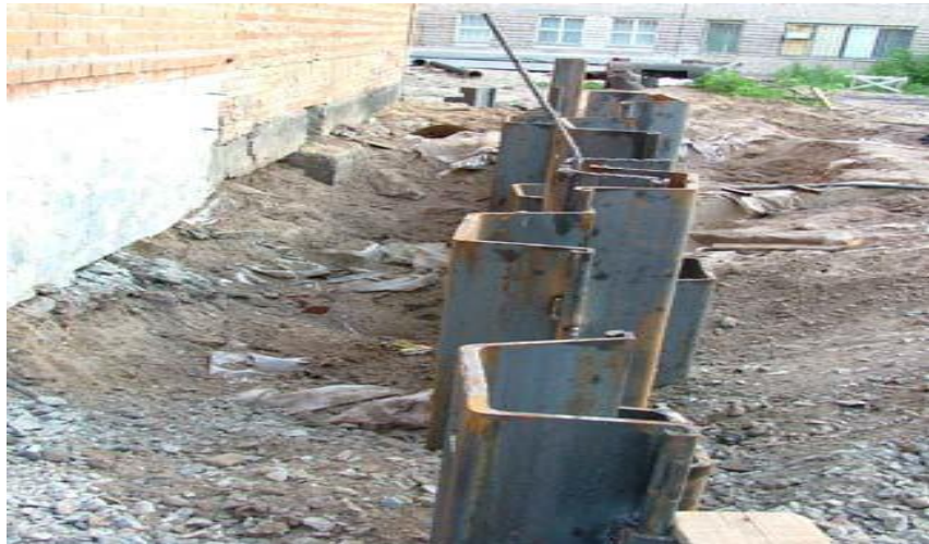
Рисунок 7.5 – Огороджувальна металева шпунтова стінка
