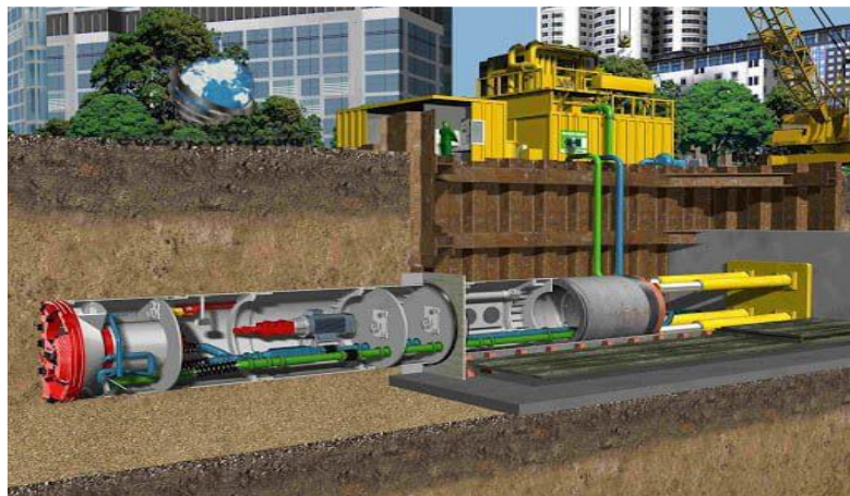
Рисунок 8.1 – Мікротунелепрохідницький комплекс
