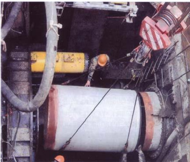
Рисунок 8.6 – Монтаж труб для задавлювання через кільце ущільнювача. Продавлювання труб із стартової шахти на будівництві
