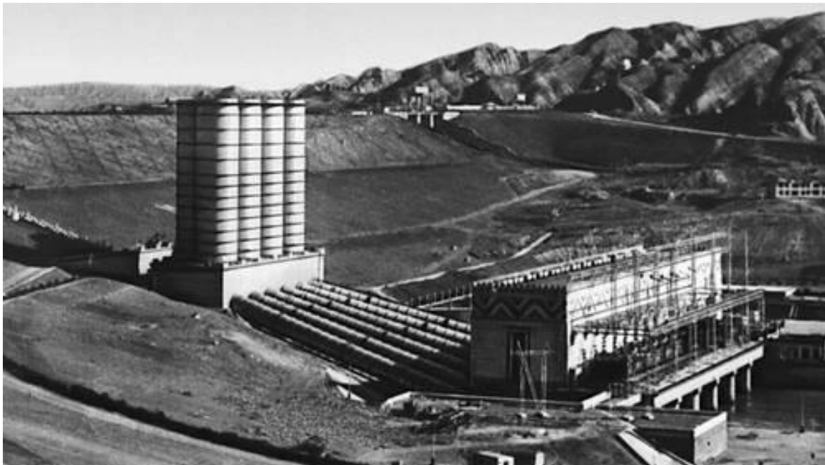
Рисунок 4.33 – Загальний вигляд дериваційної ГЕС
