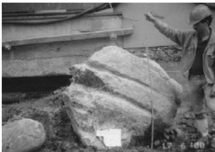
Рисунок 8.13 – Валун, витягнутий при влаштуванні котловану в Берліні
