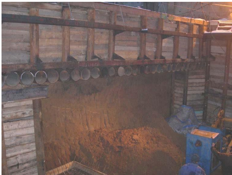
Рисунок 4.26 – Захисний екран із труб діаметром 325 мм
