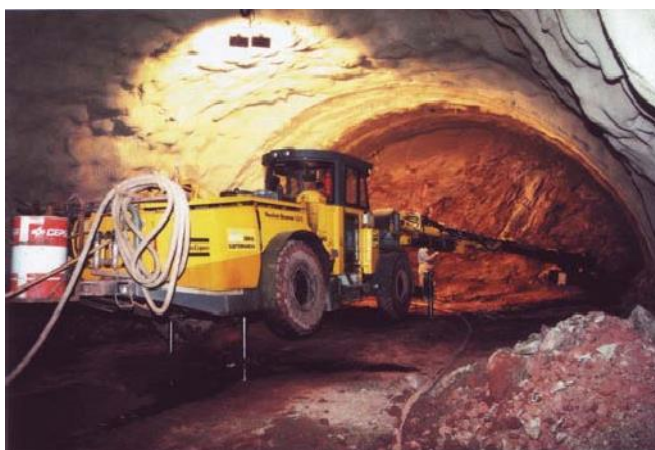
Рисунок 4.6 – Проходження верхньої частини перетину транспортного тунелю El Fabar (Іспанія)
