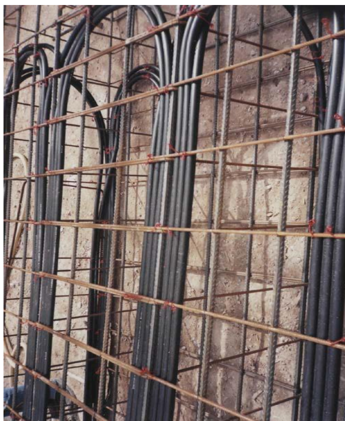
Рисунок 2.6 – Встановлення холодопровідних пластикових труб усередині каркасу фундаментів будівлі
