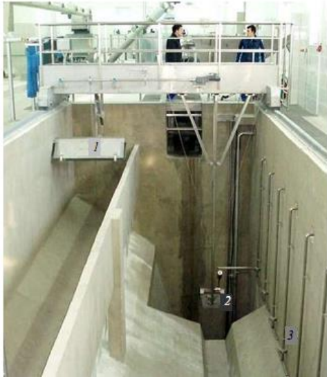
Рисунок 4.10 – Аерований пісковловлювач із видаленням піску за допомогою шкребків: 1 – поверхневий скребок для збирання плаваючих речовин; 2 – скребок для збирання піску; 3 – аератори
