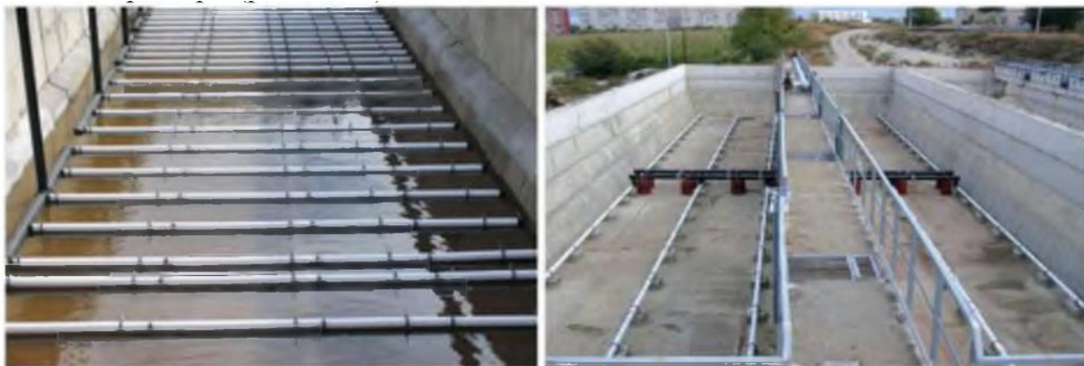
Рисунок 8.7 – Розкладка трубчастих аераторів у аеротенку
