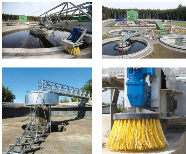
Рисунок 4.17 – Схема збору та видалення осілого осаду
