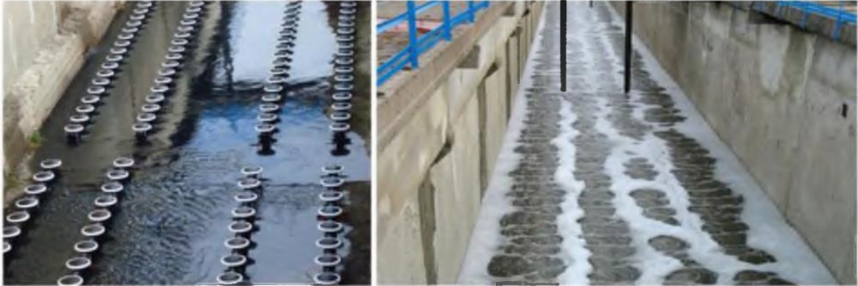
Рисунок 8.8 – Розкладка дискових аераторів в аеротенку
