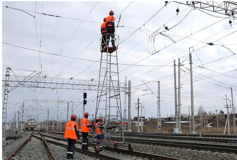
Рисунок 1.2 – Обслуговування контактної мережі
