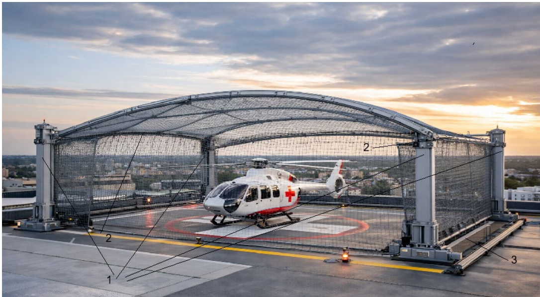
Рисунок 4.5 – Мобільна захисна сітка для гелікоптерного майданчика:
