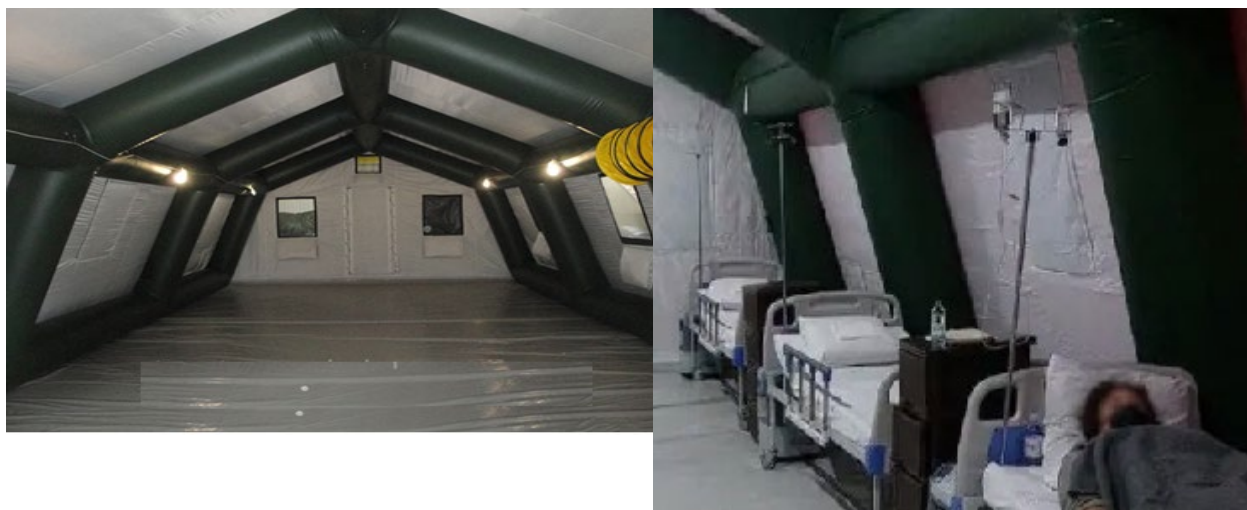
Рисунок 2.9 – Пневмокаркасна надувний намет ПНМ 6х6: внутрішній вигляд
