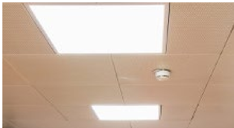
Рисунок 2.10 – Герметична медична LED-панель LEDVANCE PANEL 600x600 IP54 36W/4000 K OP WT. Приклад застосування LED-панелі
