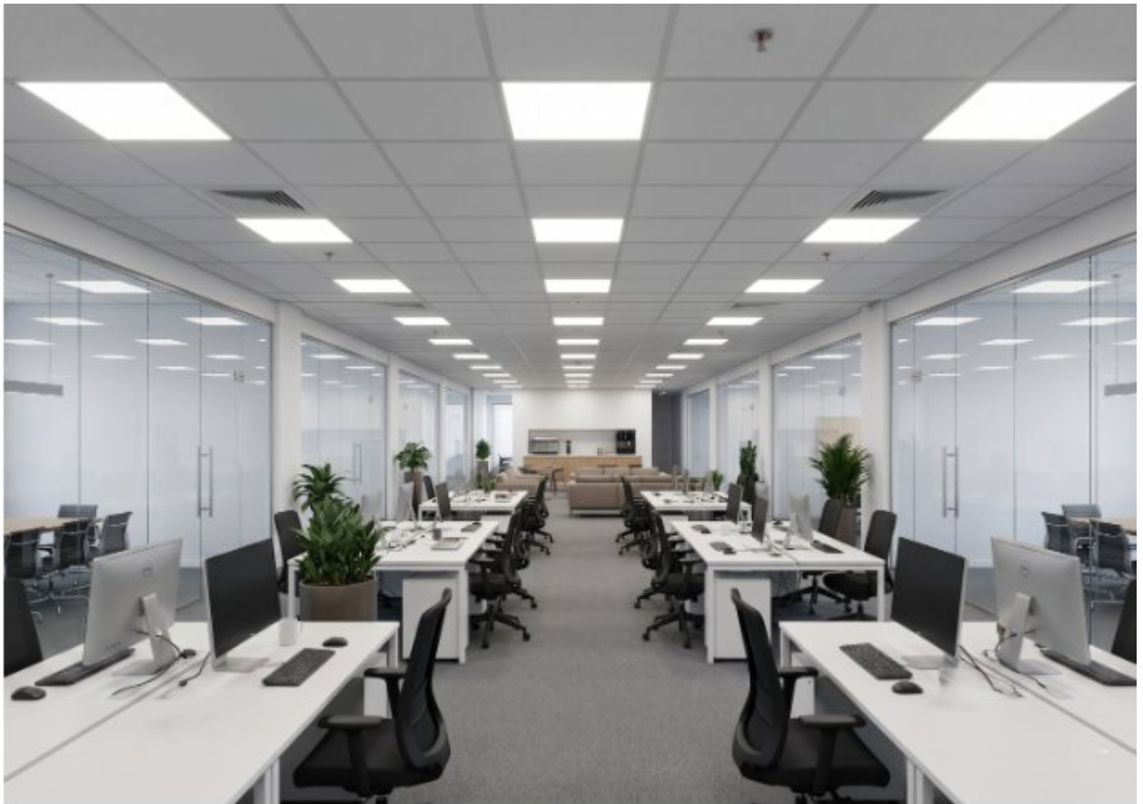
Рисунок 1.4 – Приклад застосування LED-світильника типу «Armstrong» в офісному приміщенні з відкритим робочим простором
