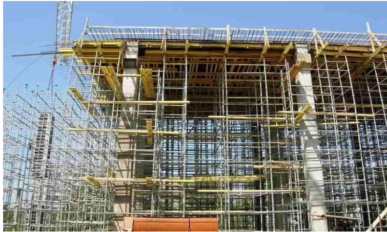
Рисунок 1.3.1.5 – Приклад рамної опалубки перекриттів
