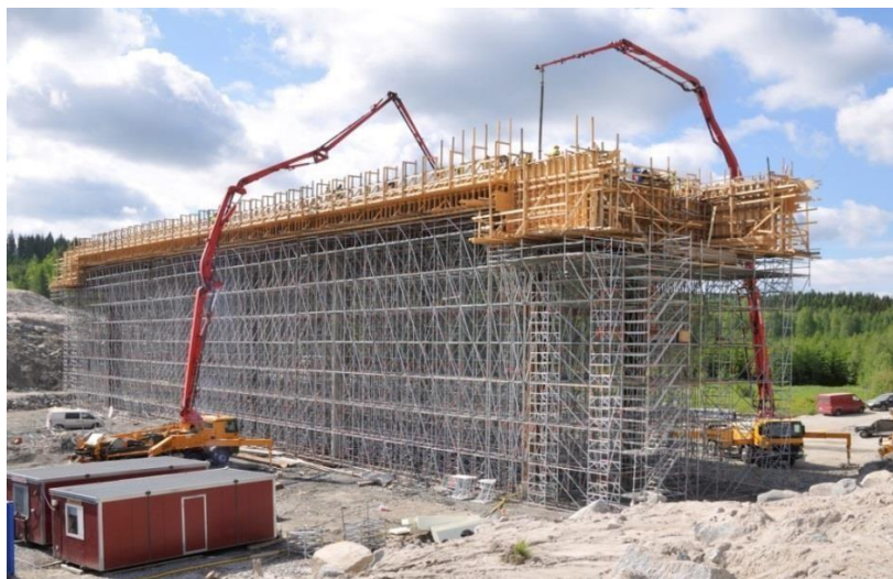
Рисунок 1.3.1.4 – Приклад опалубки перекриттів на опорних лісах
