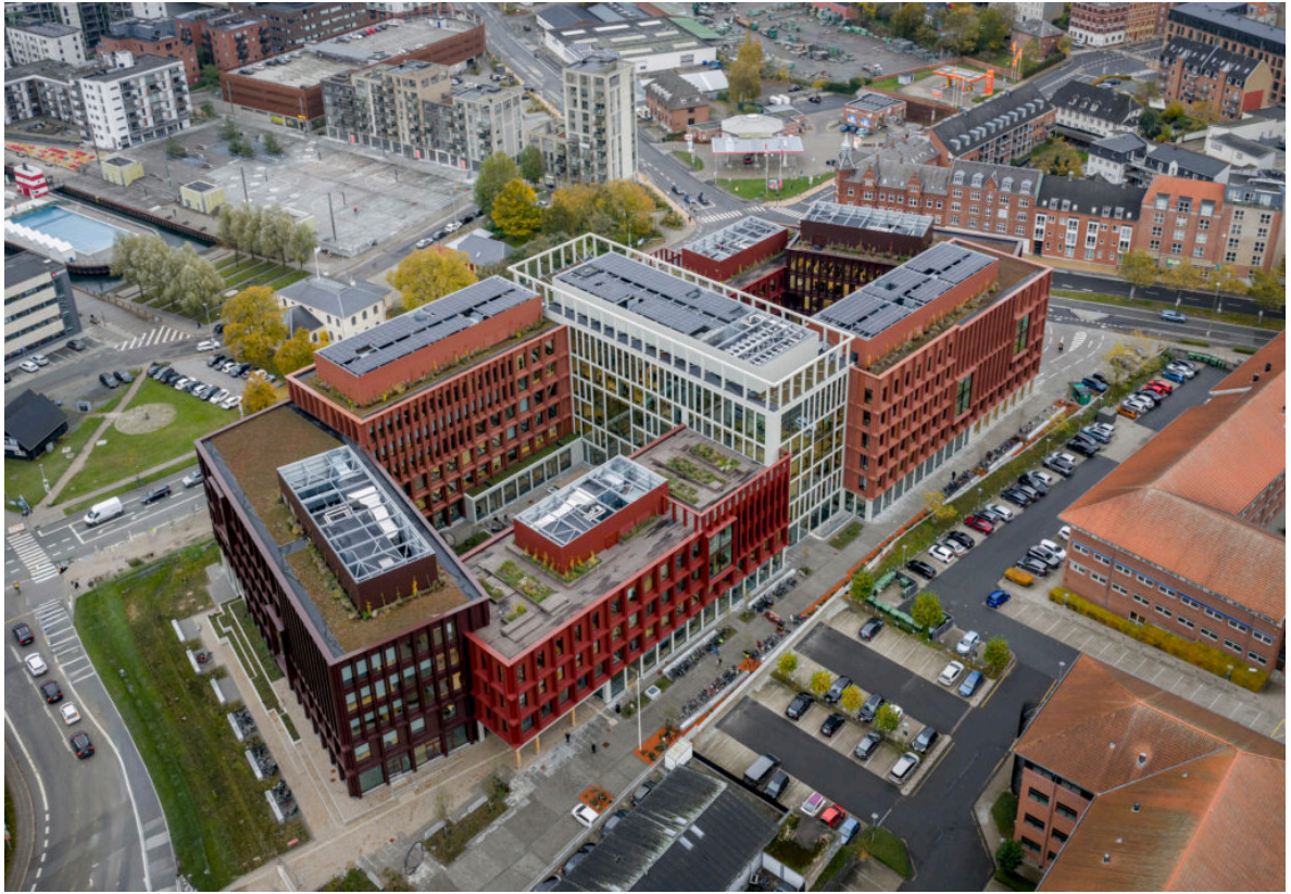
Рисунок 1.6. Вид на споруду з висоти пташиного польоту
