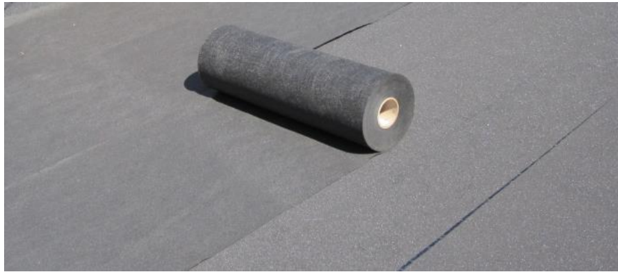
Рисунок 13.4 – Улаштування рулонної покрівлі
