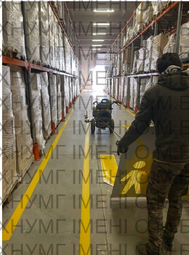
Рисунок 1.9 – Виконання робіт із нанесення складської навігації та розмітки
