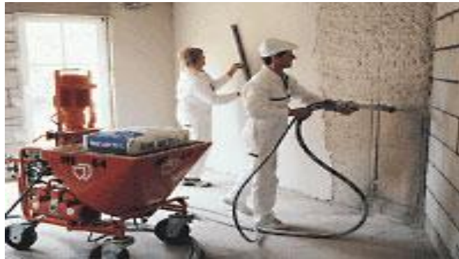
Рисунок –3.1 Штукатурка механізованим способом
