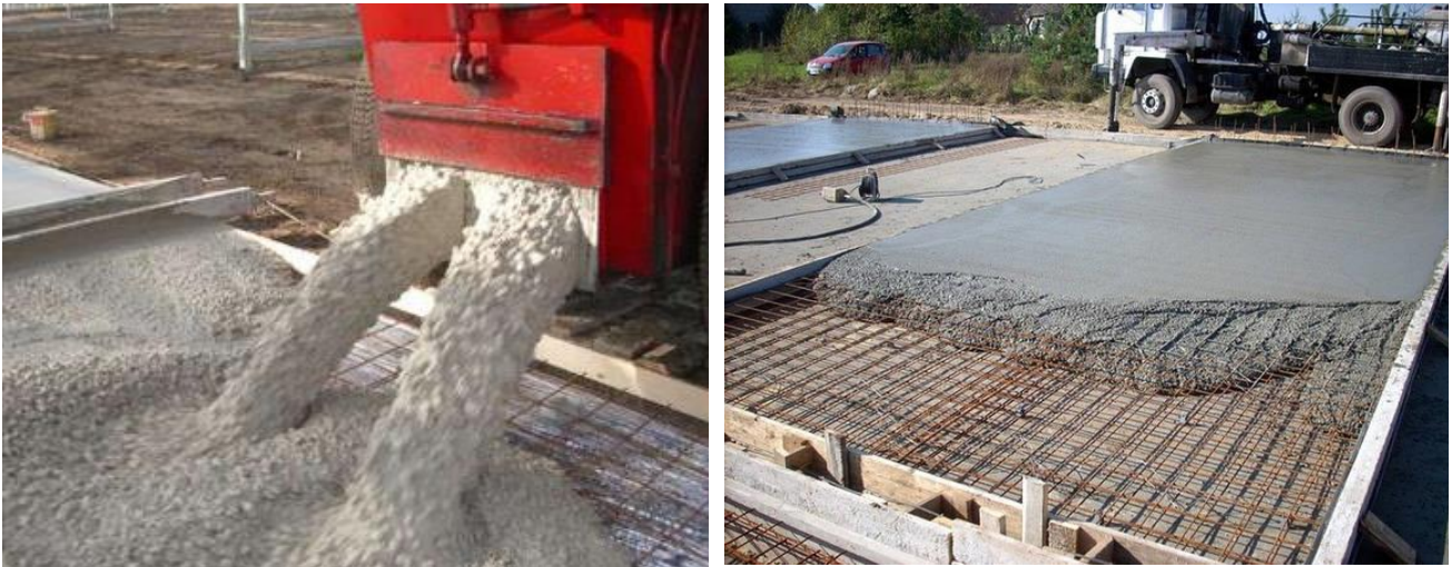
Рисунок 9.3 – Приклади монолітного будівництва
