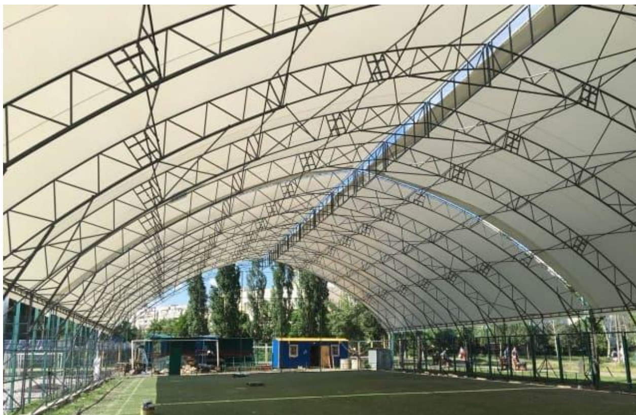
Рисунок 8.4 – Елемент даху спортивної споруди (URL: https://mestro.com.ua/uk/metalevi-fermi/ )
