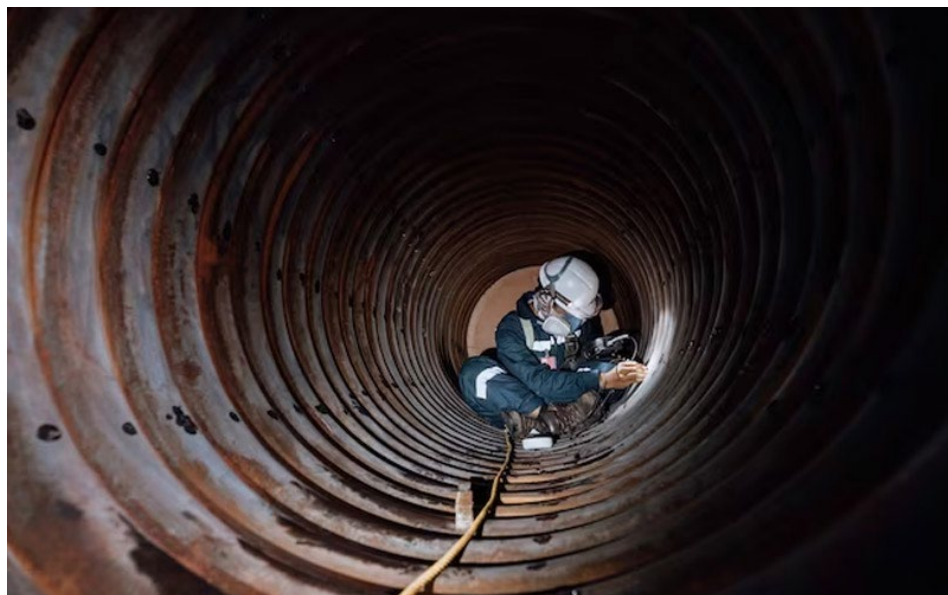
Рисунок 2.1 – Робоче місце зварника при проведенні робіт у напівзамкненому просторі
