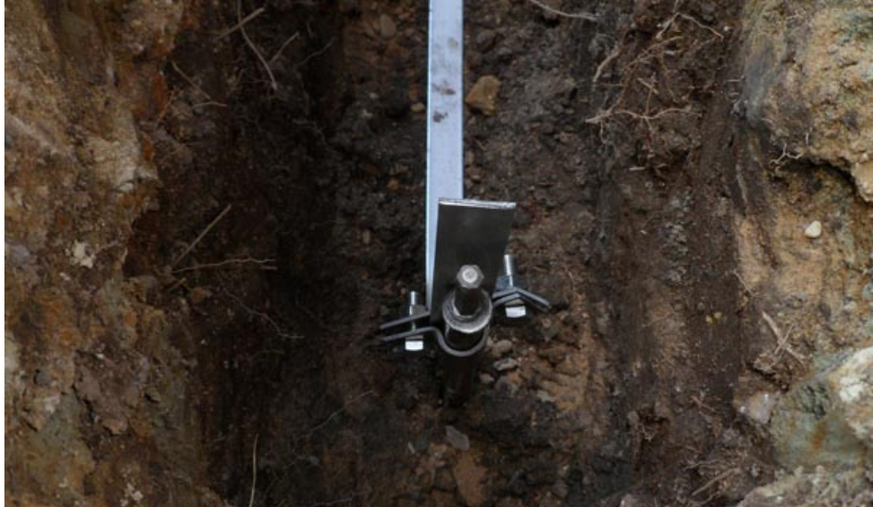
Рисунок 3.1 – Приклад монтажу захисного заземлюючого контуру
