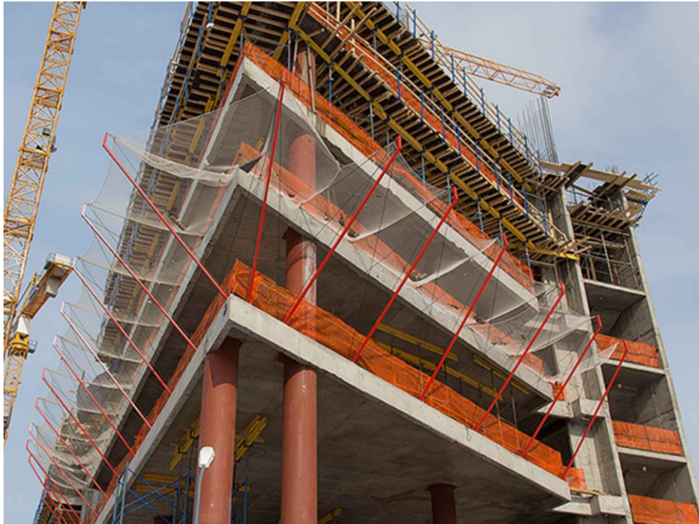
Рисунок 3.3 – Приклад монтажу захисної вловлювальної сітки
