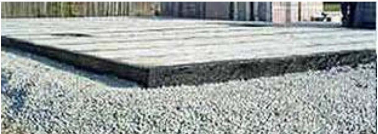
Рис. 94. - Готова монолітна плита
